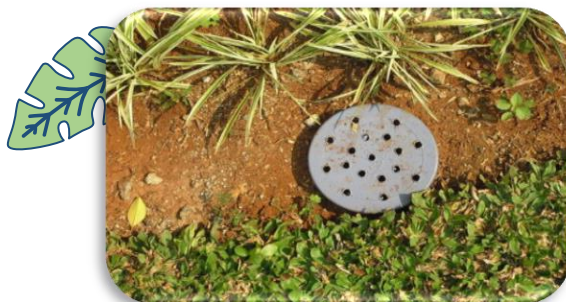
Gambar 1. 13 Biopori yang sudah dipendam Sumber: sda.pu.go.id
