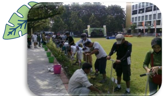
Gambar 1. 12 melubangi dengan bor biopori Sumber: sda.pu.go.id
